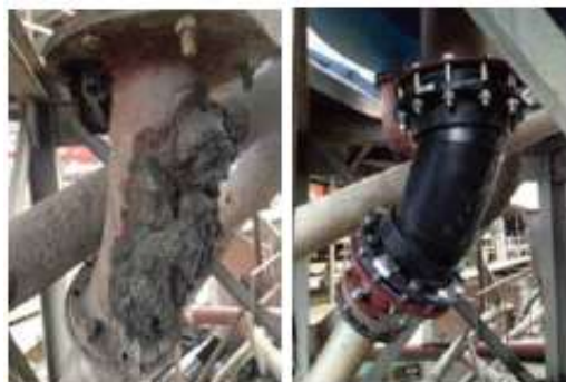
REEMPLAZO DE CODO: LINEA DE TRANSPORTE PULPA MAGNETITA DE VANADIO-TITANIO
